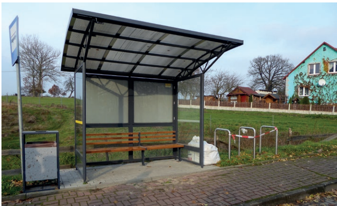
Wiata przystankowa w Złotniku.
