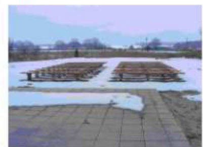
Zdjęcie przedstawia ułożony system drenażarski przed ułożeniem podbudowy.
